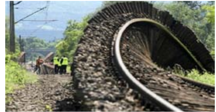
รางรถไฟที่เสียหายจากน้ำท่วมครั้งรุนแรงที่โปแลนด์
